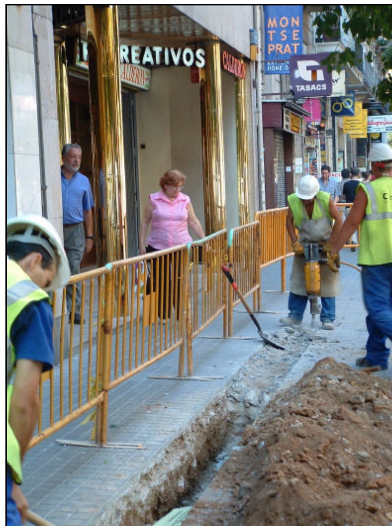
Fotografia 2. Treballs obertura de la rasa realitzada al carrer Fontanelles. Vista en direcció Plaça Urquinaona.
